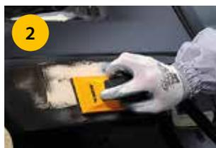
Выровняйте зашпатлеванный участок. Используйте сетчатую полосу P80 или P120 со шлифовальным блоком или машинкой Mirka® OS 383.
